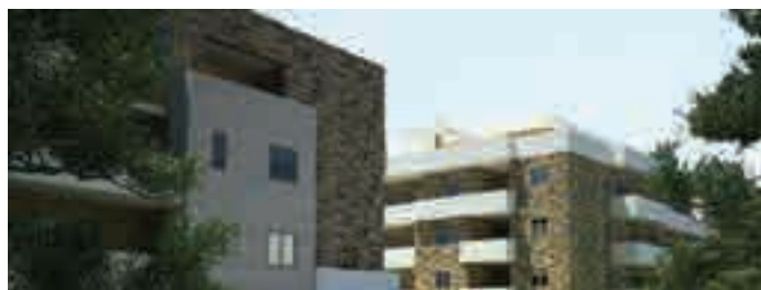
56 FOCUS IMMOBILI Parco Residenziale, Poggetto, Residenze Valle Copella, Cantiere Fiorentino, Cantiere Gubbio, Edil Massimina, Fintiba, Edil car, Rondinara
